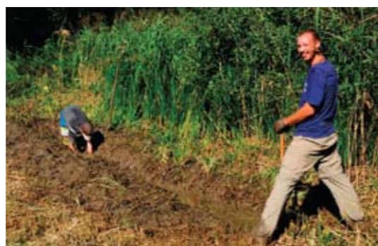
▲ Händische Reaktivierung eines Entwässerungsgrabens. G.N.
